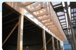
木造フレーム&パネル工法 （建築中の店舗入り口）
