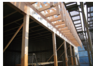
木造FP工法(建築中の店舗入口)
