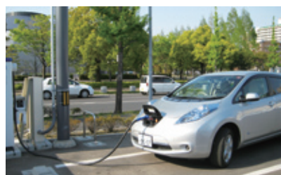
電気自動車の急速充電器を設置
